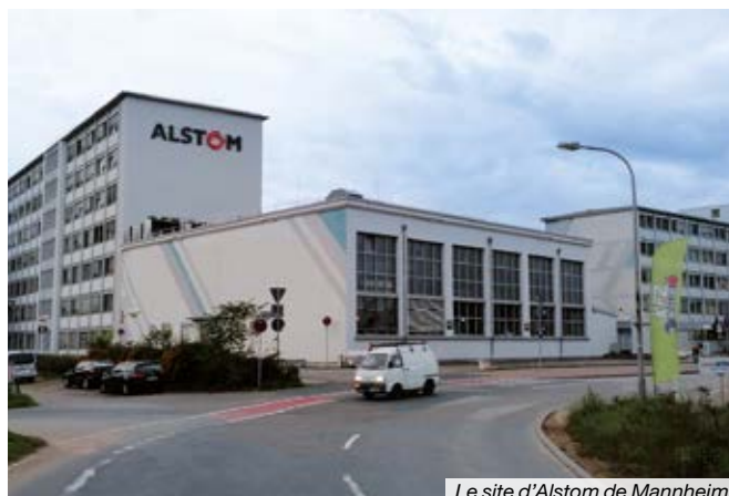
Le site d'Alstom de Mannheim
