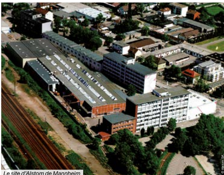
Le site d'Alstom de Mannheim
